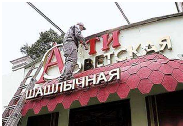
Демонтаж вывески шашлычной
