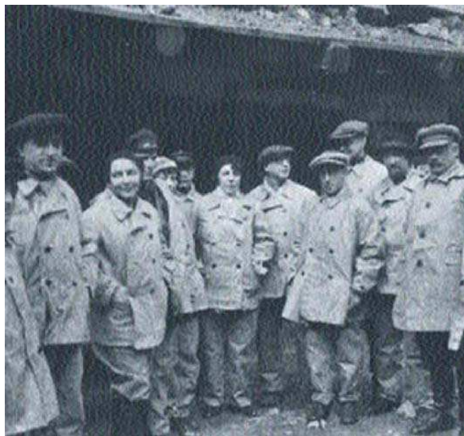
На строительстве московского метро. 1933 год.
