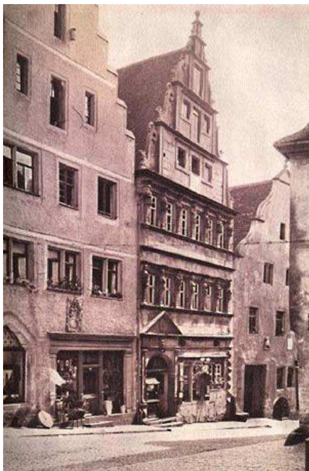
Ротенбург. Дом строительного цеха.
