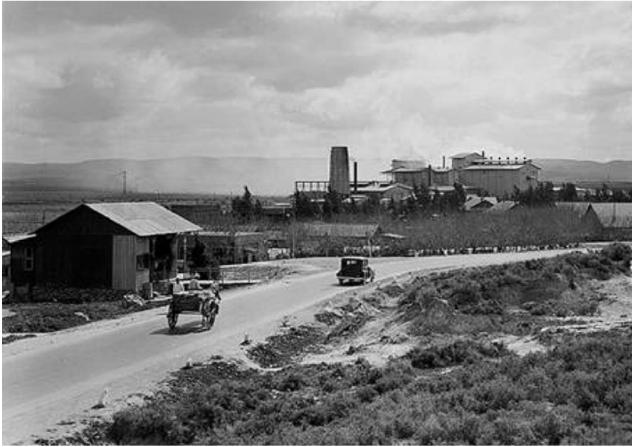
Цементный завод «Nesher Cement Works». 1930-е годы
