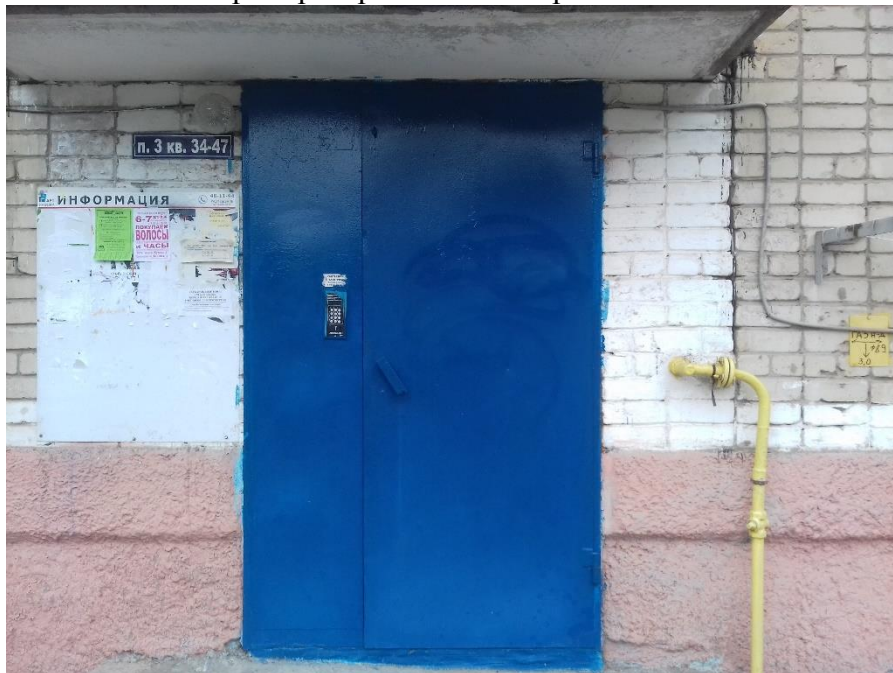
Фото № 1 Общий вид входной двери подъезда
