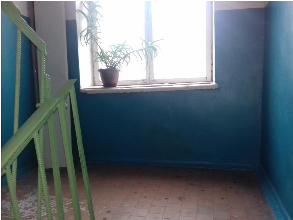
Фото № 9 Общий вид лестничной площадки между четвертым и пятым этажами
