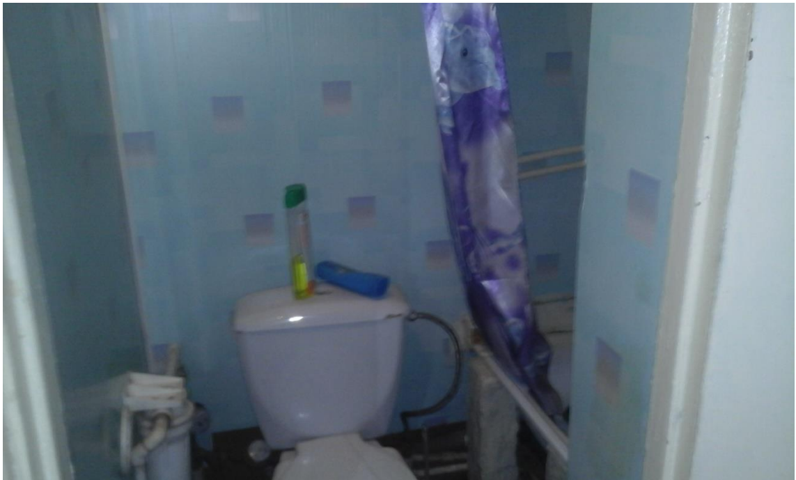
Фото № 5: совмещенный санузел кв. 132 дома №28 м-на Интернациональный г. Старый Оскол
