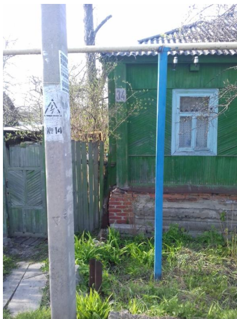
Фото № 1 Общий вид домовладения № 34 ул. Вагонная г. Старый Оскол
