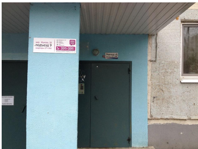
Фото № 2: общий вид подъезда №9 дома №28 м-на Жукова г. Старый Оскол
