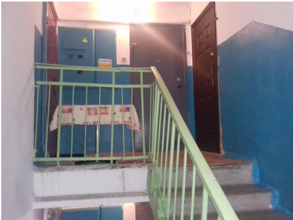
Фото № 10 Общий вид лестничной площадки пятого этажа
