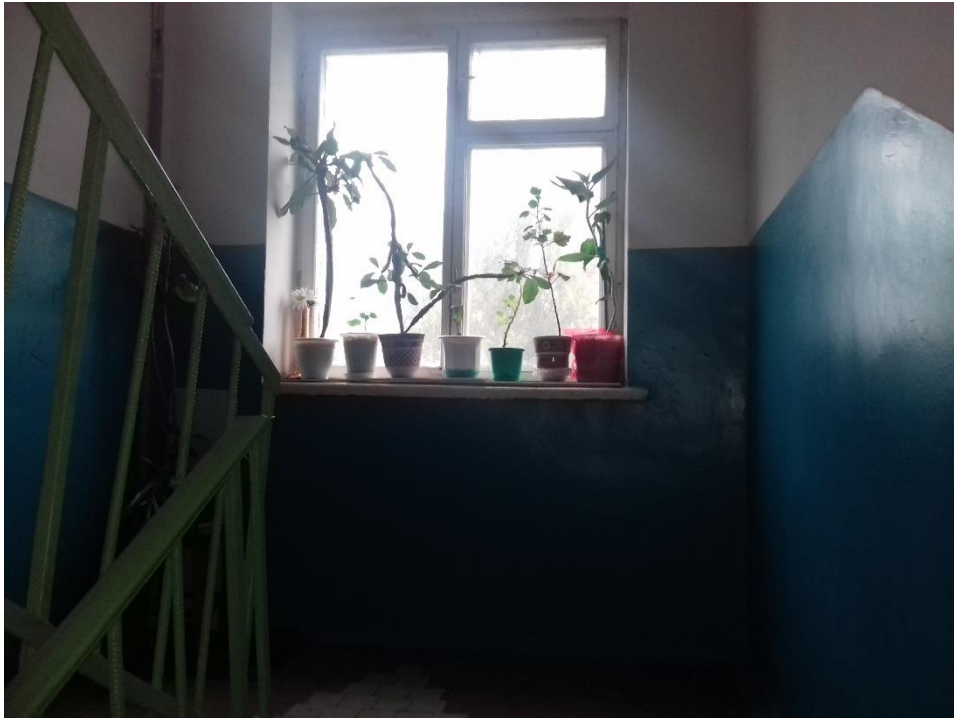
Фото № 7 Общий вид лестничной площадки между третьим и четвертым этажами
