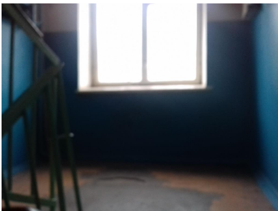
Фото № 3 Общий вид лестничной площадки между первым и вторым этажами.
