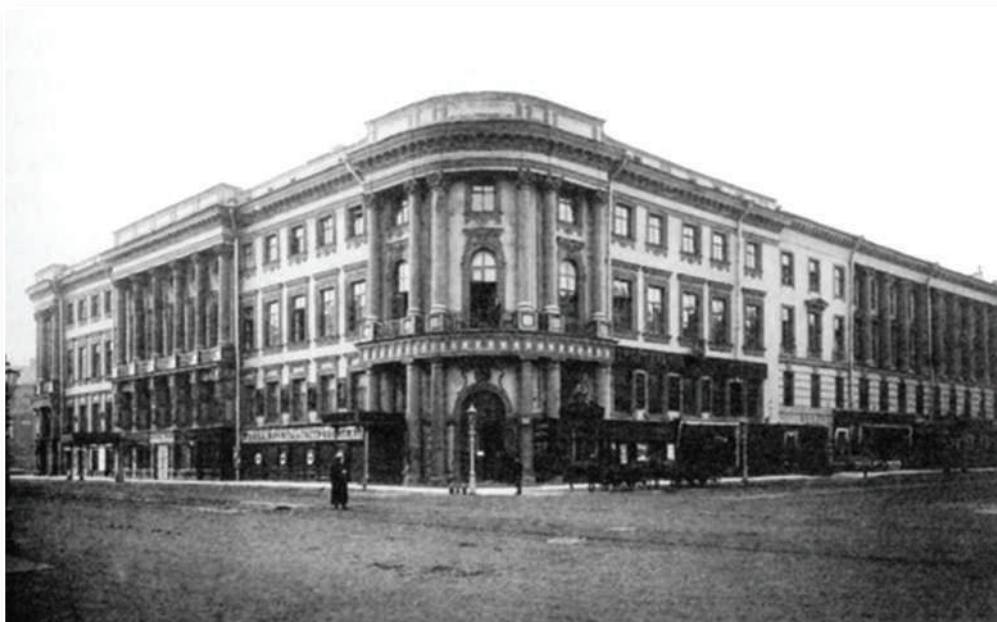
Дом генерал-полицмейстера на углу Невского проспекта и Мойки.
