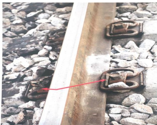
Рис. 15. Шпалы и скрепления
