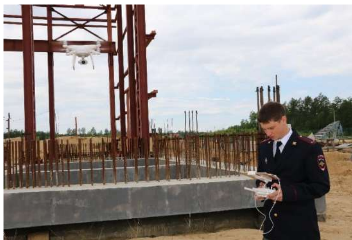
Рис. 2. Работа эксперта с беспилотным летательным аппаратом при натурном осмотре строительных объектов и территории, функционально связанной с ними
