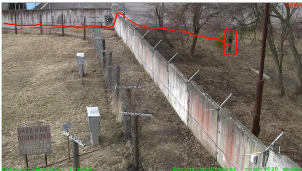
Рис. 3.20. Пример работы периметральной видеоаналитики
