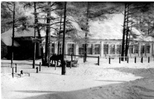
Здание Кривандинской начальной школы. Фото с сайта krivandino.ru
