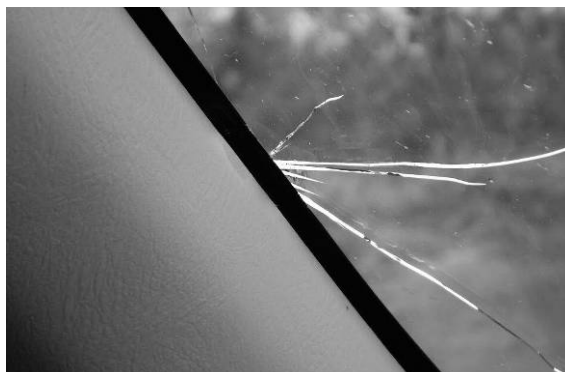
Рис. 7. Образование веера трещин от дефекта кромки
