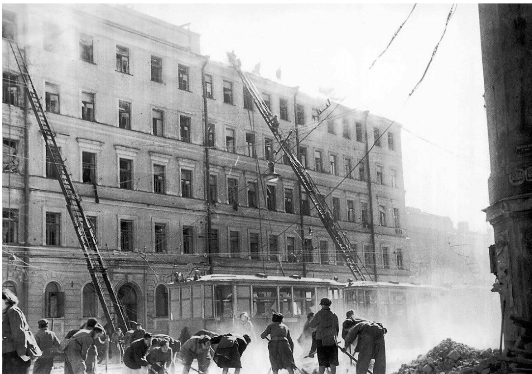
Проведение аварийно-восстановительных работ и разбор завалов
