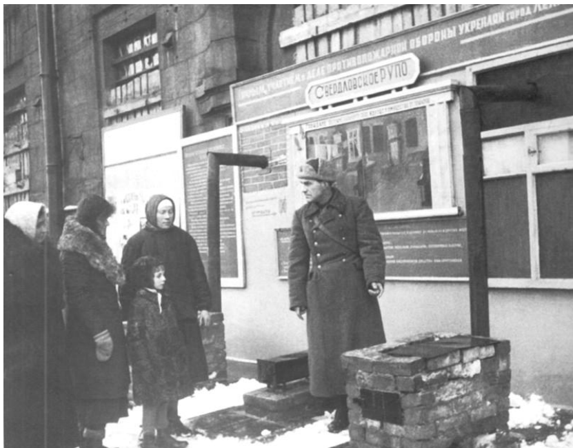
Инструктаж правил пожарной безопасности при эксплуатации печей
