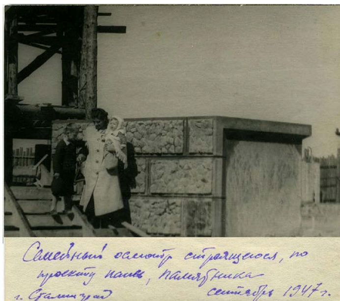
Рис. 8. Супруга автора проекта с сыновьями. Надпись на обороте: «Семейный осмотр строящегося по проекту папы памятника, г. Сталинград, сентябрь 1947 г.»
