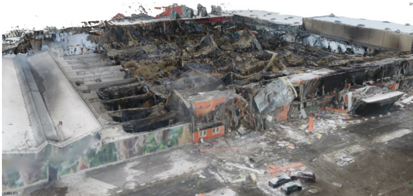
Рис. 10. Объект пожара, снятый с помощью БВС
