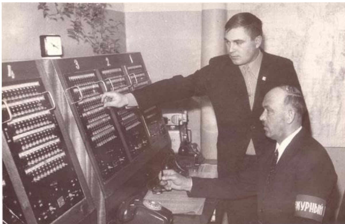
Рис 1. Пульт централизованной охраны
