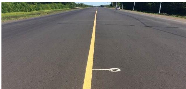
Рис. 4. Временная дорожная разметка на участке автодороги «Орёл – Тамбов»
