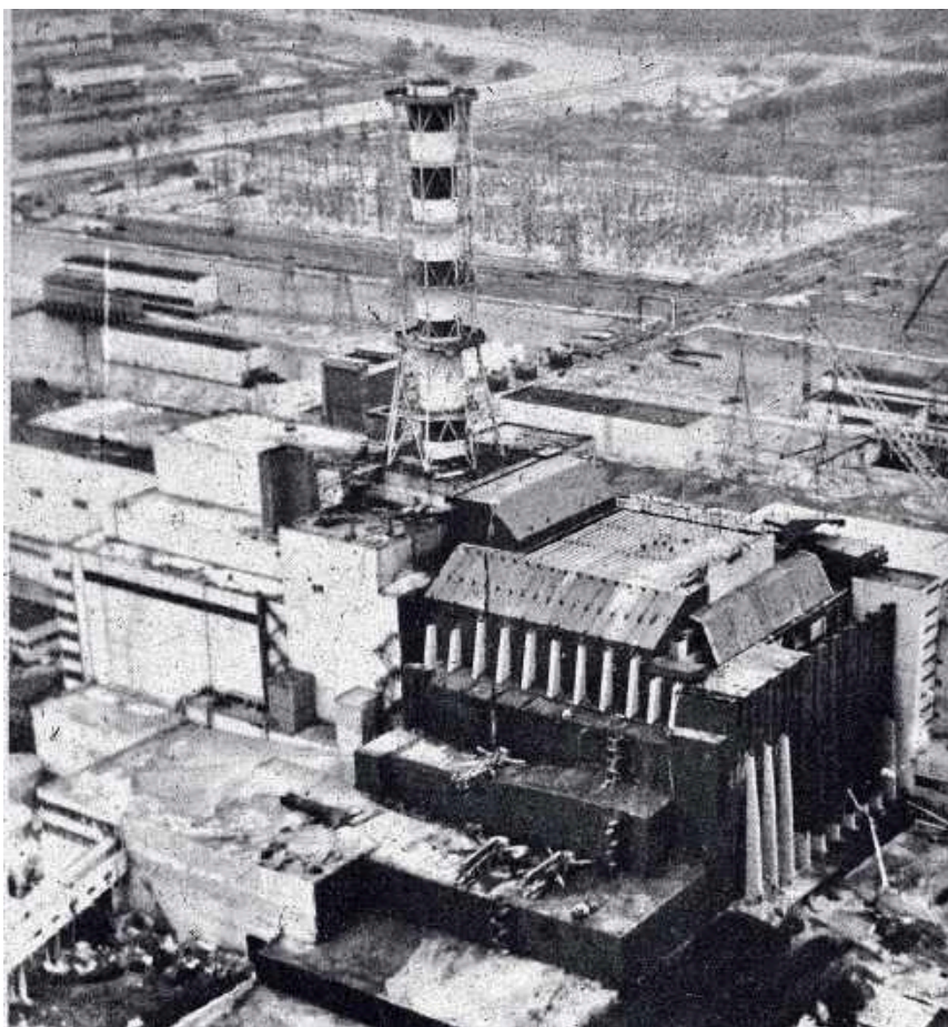
МОНТАЖ ОПОР ДЛЯ СООРУЖЕНИЯ УКРЫТИЯ НАД 4-М ЭНЕРГОБЛОКОМ, 1986 ГОД
