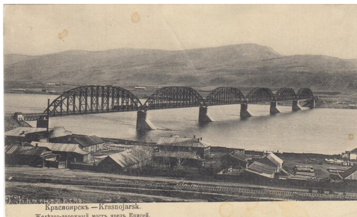
Красноярский железнодорожный мост через Енисей
