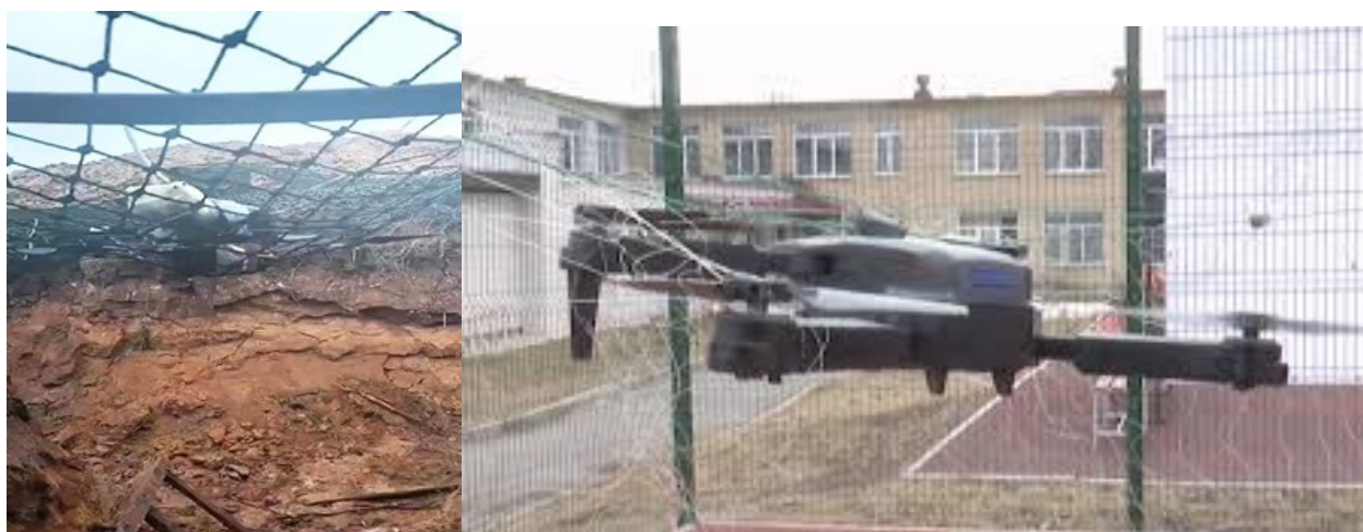
Рисунок 42. Пример защиты объектов от БВС при помощи сетей
