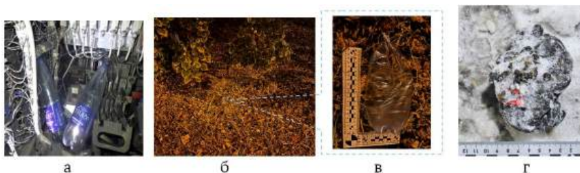
Рис. 5. Пластиковые бутылки, обнаруженные внутри электрощита (а) и на прилегающей территории, около сгоревшего промышленного здания (б, в, г)
