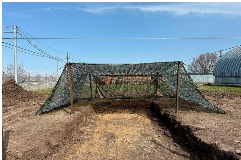
Рис. 9. Внешний вид защитного экрана от дронов-камикадзе
