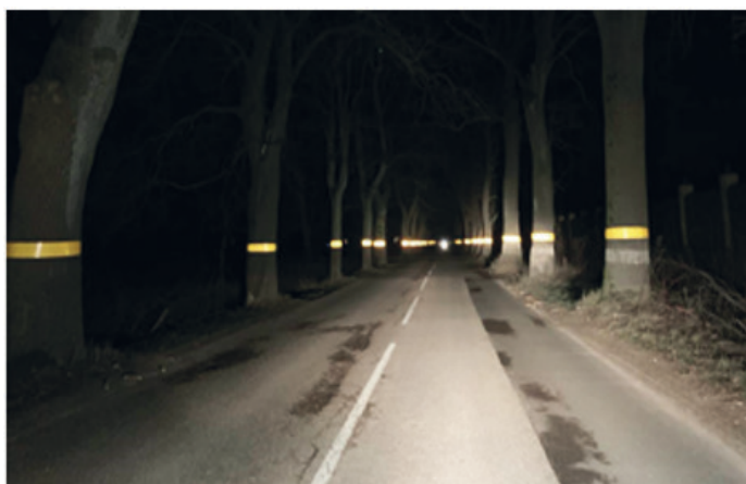
Рисунок 3 – Световозвращающие наклейки на деревья, применяемые в Калининградской области (а/д «Заозерье – Заречье – Добрино – Узловое – Заливное»)
