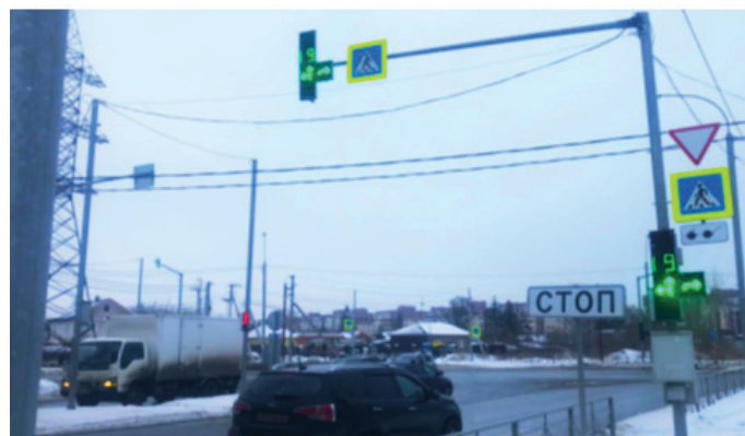
Рисунок 8 – Применение контурных стрелок на сигналах светофора Т.1 (г. Новосибирск, ул. 2-я Станционная и Большая)
