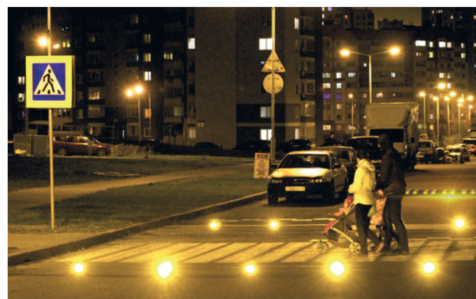
Рисунок 9 – Светодиодные маячки на проезжей части в местах применения световозвращателей вблизи полос разметки 1.14.1
