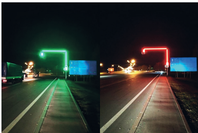
Рисунок 10 – Дублирование сигналов транспортных светофоров подсветкой светофорных консолей (г. Уфа)
