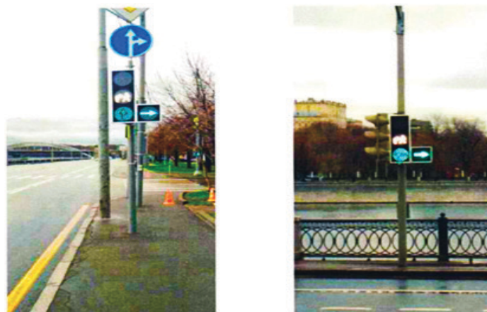
Рисунок 4 – Применение информационной световой секции для предупреждения водителей о возможном движении пешеходов по пешеходному переходу в секции желтого сигнала светофора (г. Москва, Бережковская набережная)
