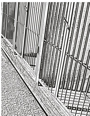
Рисунок 14. Желоб для стока дождевых и талых вод, а также для смыва нечистот при уборке
