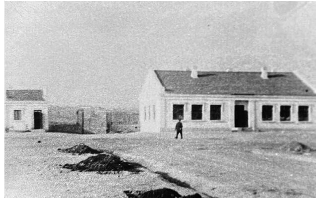
Строительство зданий питомника (сейчас это КПП и цикл кинологии), 1948 год
