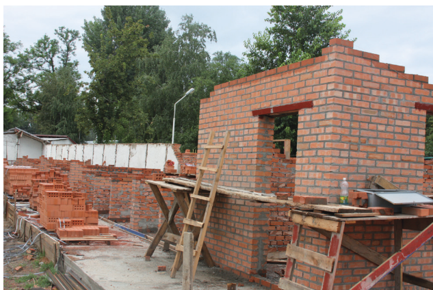
Строительство блока вольеров
