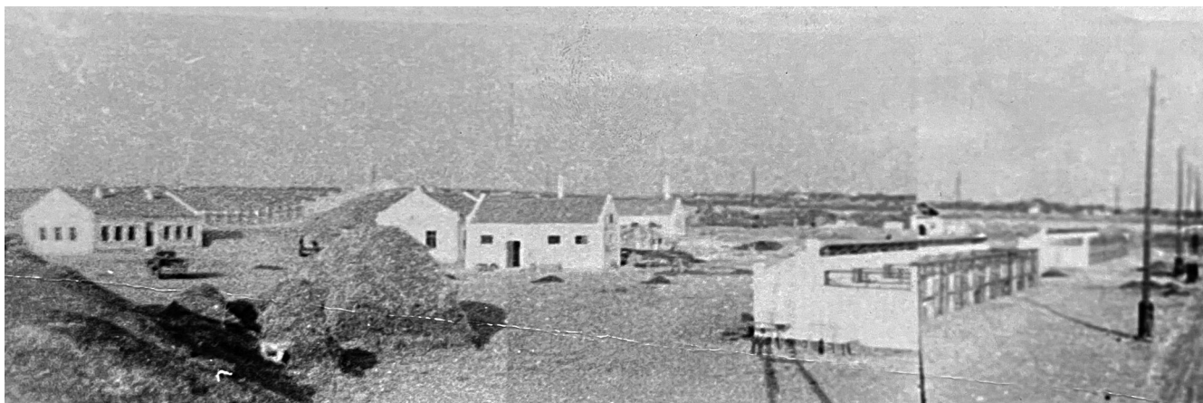
Вид строящегося питомника с западной стороны
