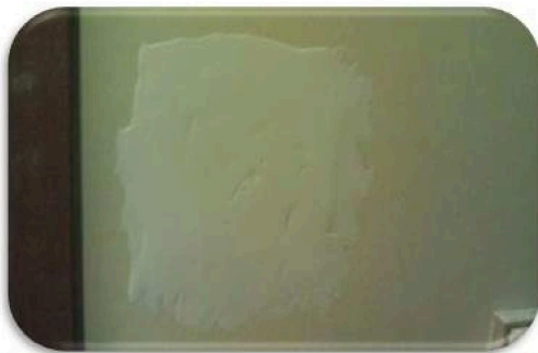
- наличие свежих кладок, штукатурки, бетонирования;
